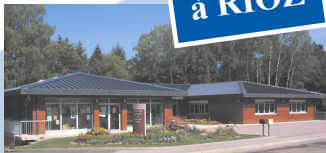
Maison de services au public
