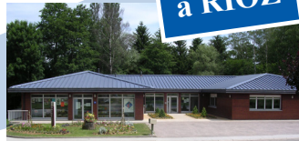
Maison de services au public
