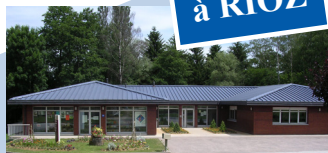
Maison de services au public
